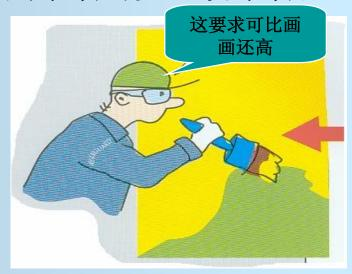
●一次涂刷无法达到 0.5-0.8mm厚度, 可以在凝胶后的第一层上再刷一层
